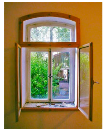
Abb. 1: Doppelfenster alter Bauart
